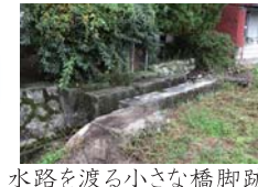
小さな橋脚の跡
