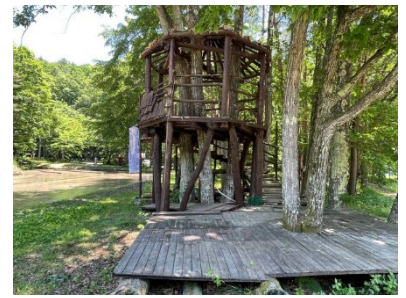
屋根カバーを撤去したツリーハウス
