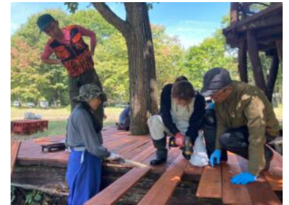
杉板に防腐剤を塗って貼りました
